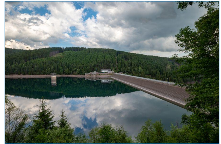
Staudamm und Entnahmeturm der Ohra-Talsperre (© TFW AöR)
